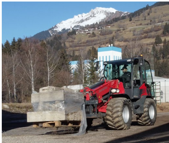
Sur le site de l'entreprise de construction, le 6680 T est utilisé pour les activités de transport et de chargement générales.
