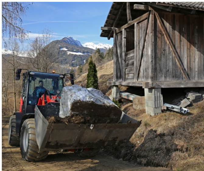
La construction de murs de soutènement en terrain montagneux, en conditions difficiles et avec une lourde charge, fait partie du domaine de spécialité des frères Gschnitzer.
